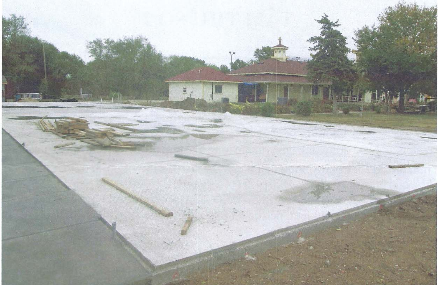
Nền móng Hội trường mới đổ bê tông 120 Feet dài, 40 feet rộng
